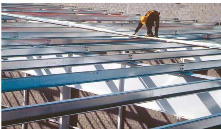
Por sus características técnicas, los perfiles conformados en frío resultan la mejor opción cuando se requiere flexibilidad y rapidez. Hay dos tipos: los perfiles abiertos en forma de "U" y los perfiles abiertos en forma de "C".
